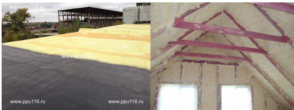
Рисунок 7.1 Напыление ППУ
